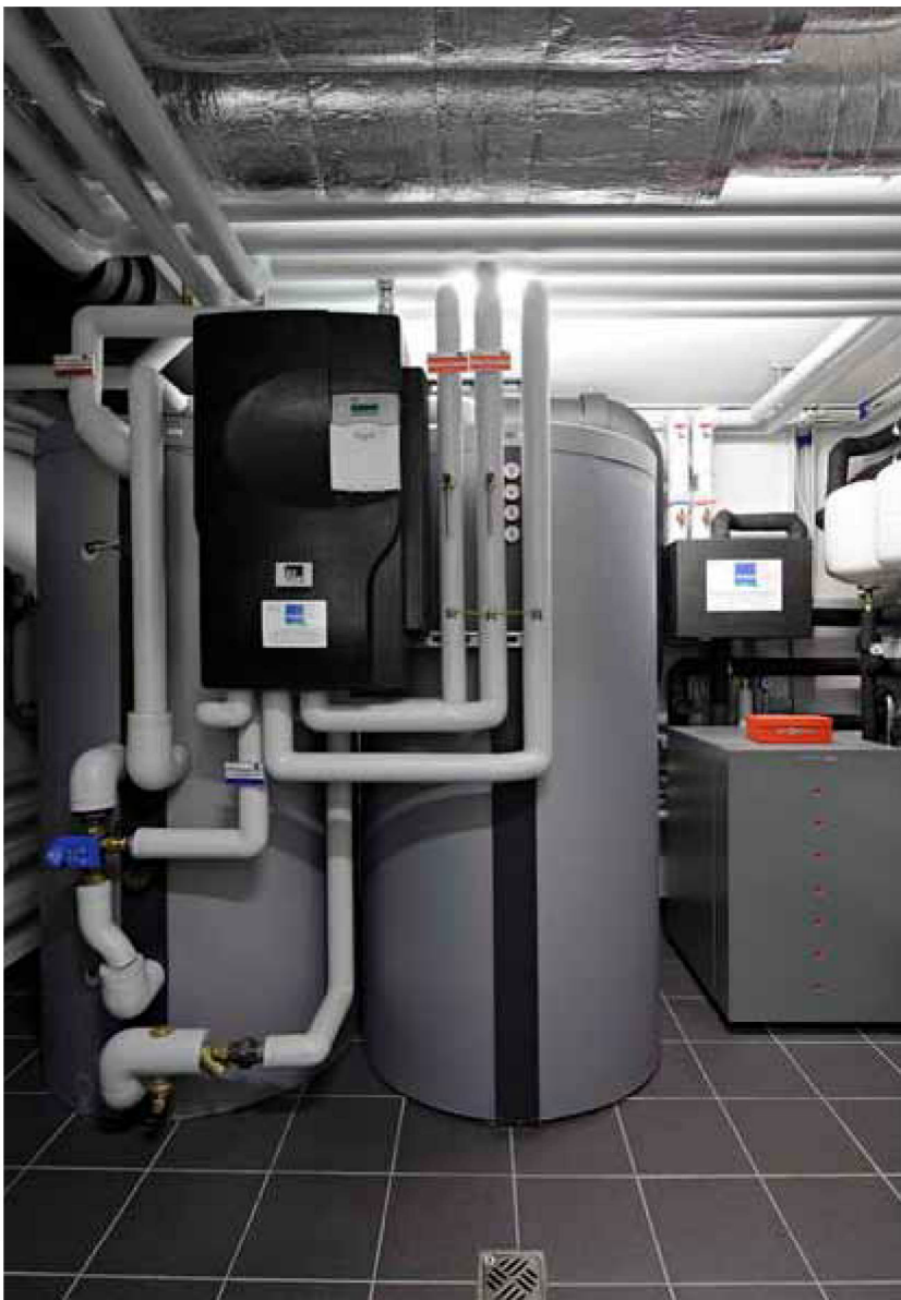
Im Technikraum des Kellers: Frischwasserstation mit zwei Pufferspeichern.
