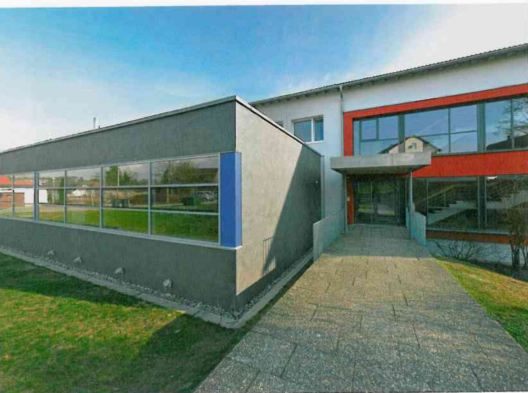
Die Grund- und Hauptschule mit Werkrealschule in Schopfloch wurde mit Mitteln aus dem zweiten staatlichen und dem Schüco Energy 2 Konjunkturpaket saniert.
